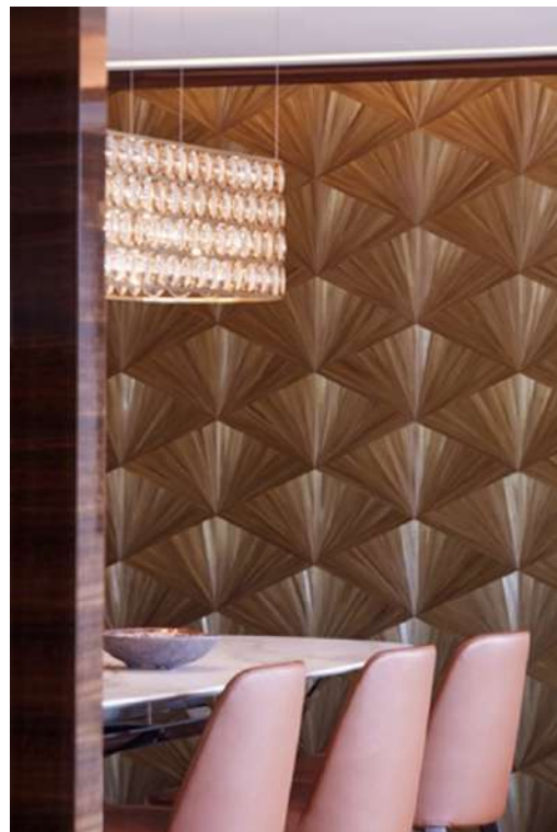
Panneaux muraux en marqueterie de paille en motif éventail par les Ateliers Lison de Caunes dans l'une des suites du Bvlgari Hôtel à Paris © Ateliers Lison de Caunes
